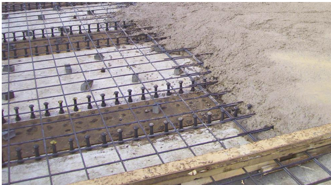
Obr. 19 Aplikace spřahovacích šroubů TCB
